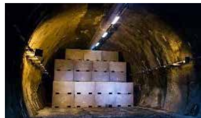
6. ábra A bátaapáti Nemzeti Radioaktív hulladék-tároló (NRHT) felszíni létesítményei és az első feltöltött tárolókamrája
