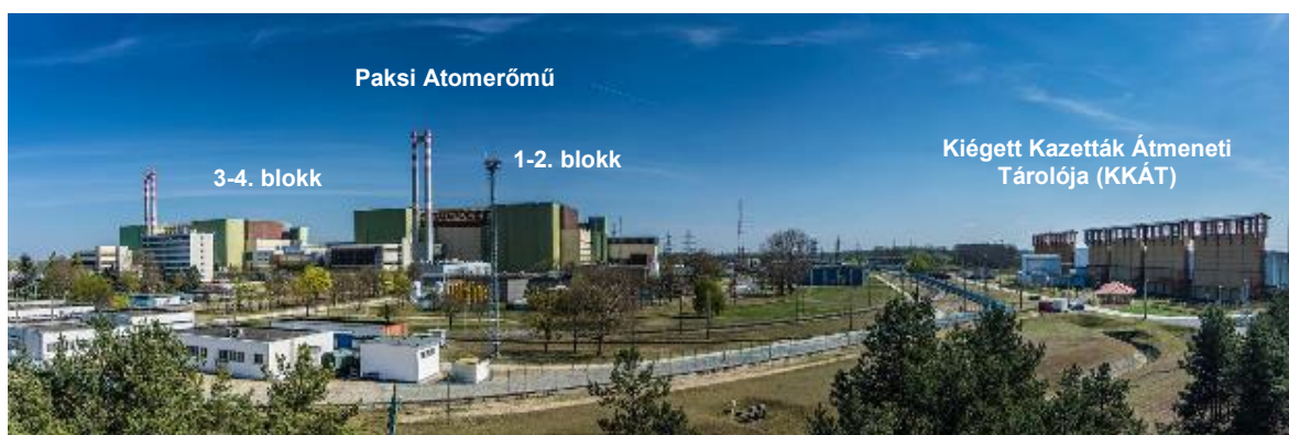
2.2-1. ábra: A KKÁT és a Paksi Atomerőmű főépületei
