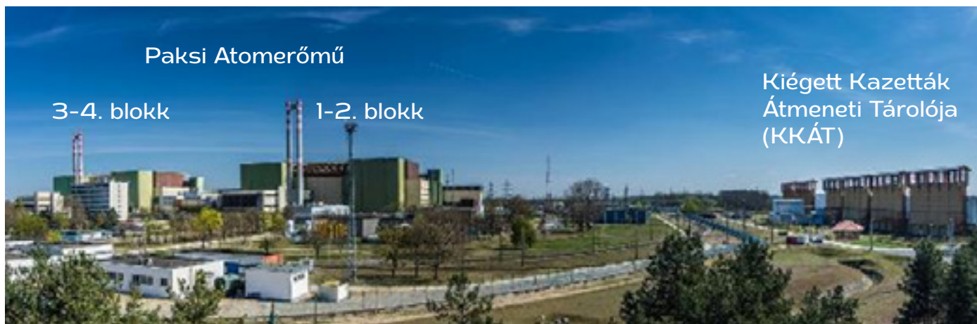
2.1-3. ábra: A KKÁT és a Paksi Atomerőmű főépületei
