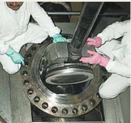
A főelzáró tolózár osztósíkjának ellenőrzése
