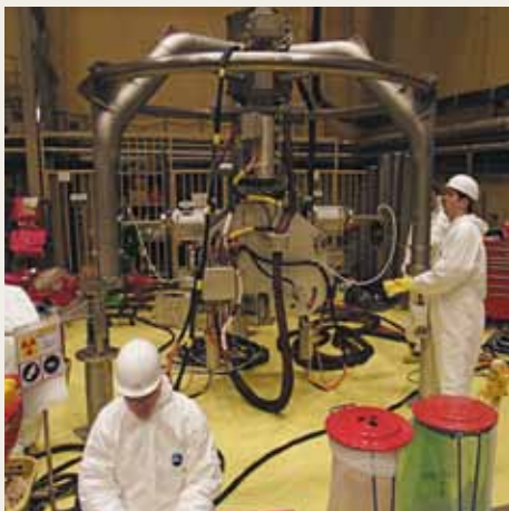
A reaktortartály roncsolásmentes anyagvizsgálatához szükséges manipulátor előkészítése
