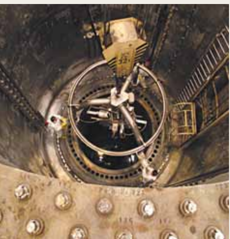
A manipulátor tartályba helyezése
