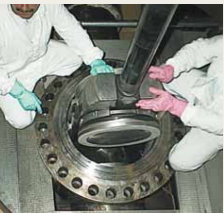
A főelzáró tolózár osztósíkjának ellenőrzése
