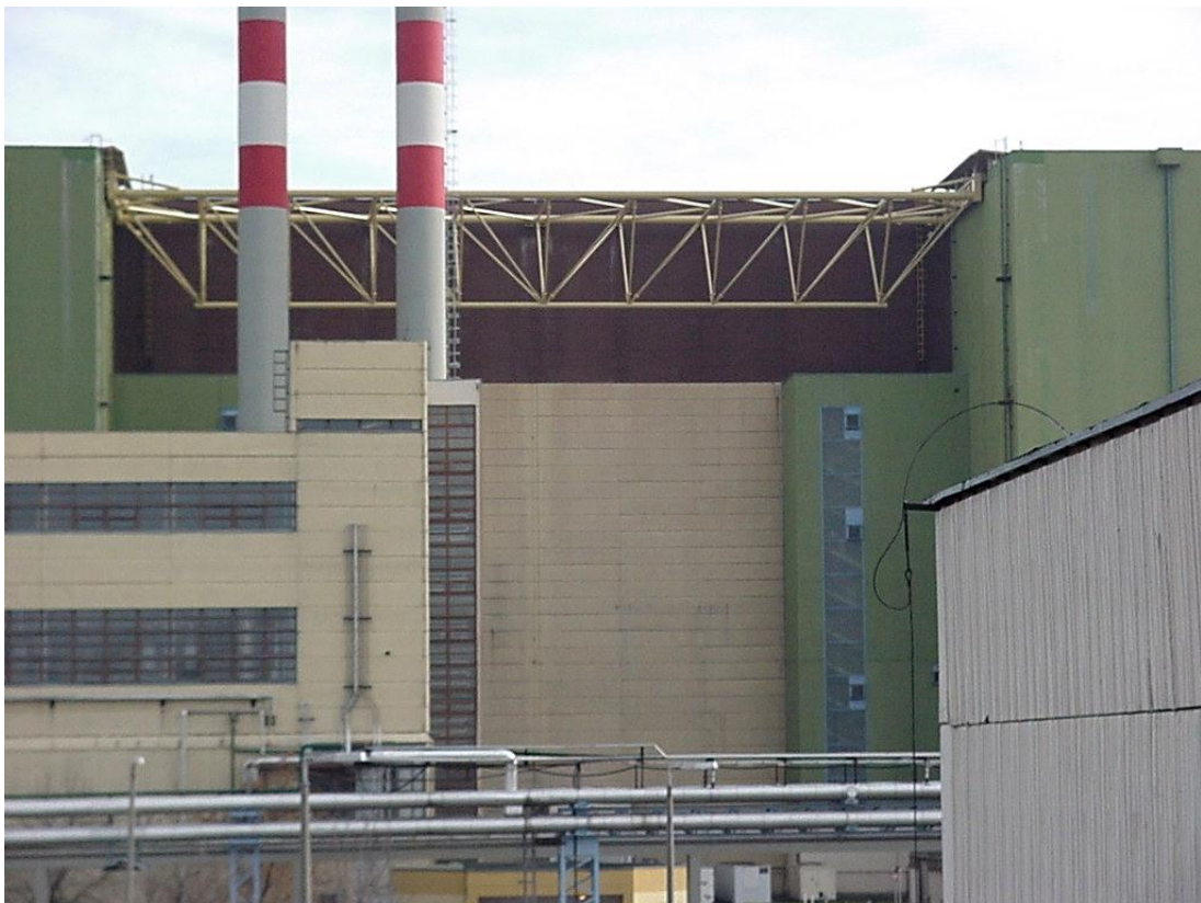
3. ábra. Hídszerkezet a lokalizációs tornyok között a reaktorcsarnok szerkezetének megerősítésére
