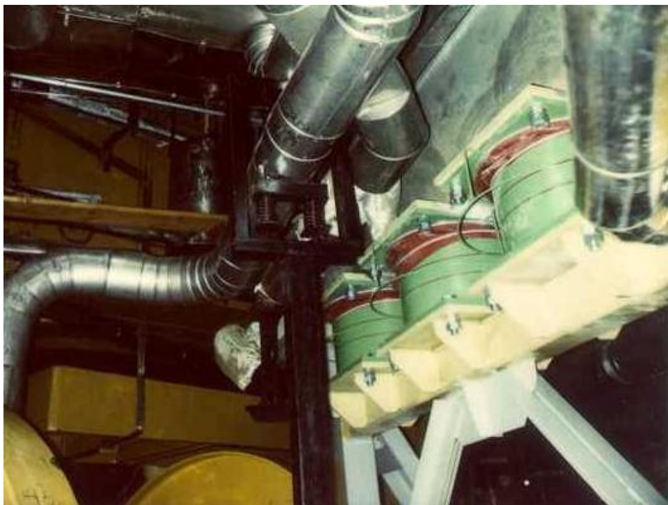
1. ábra. Viszkózus lengéscsillapítók a gőzfejlesztők alatt
