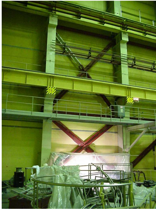
2. ábra: Hosszirányú megerősítések a reaktorcsarnokban
